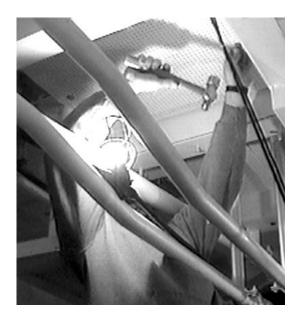
Figure 13. Insulation Installer Hammering Stud Caps Down
