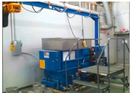
Operación de desengrase de piezas eléctricas
