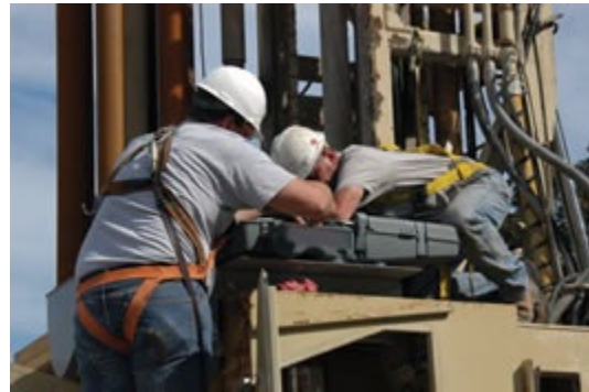
Figura 2. Instalación de un sistema unidireccional de filtración y presurización de la cabina. El sistema unidireccional introduce todo el aire filtrado en la cabina cerrada a través del techo y extrae todo el aire recirculado desde el piso de la cabina hacia la unidad de filtrado principal para su reprocesamiento.
