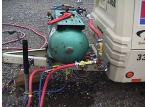
Figura 3 Tanque de agua instalado sobre un compresor remolque.
