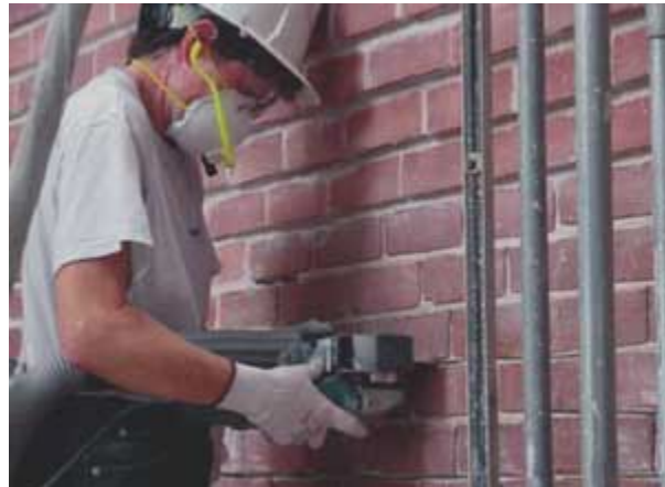
Figura 2 Mantenga la herramienta en contra de la superficie de tal manera que la manguera de escape absorba el polvo.
