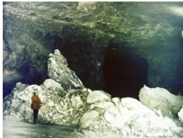
Figura 1. Derrumbe grande de rocas en una mina subterránea de piedra caliza.
