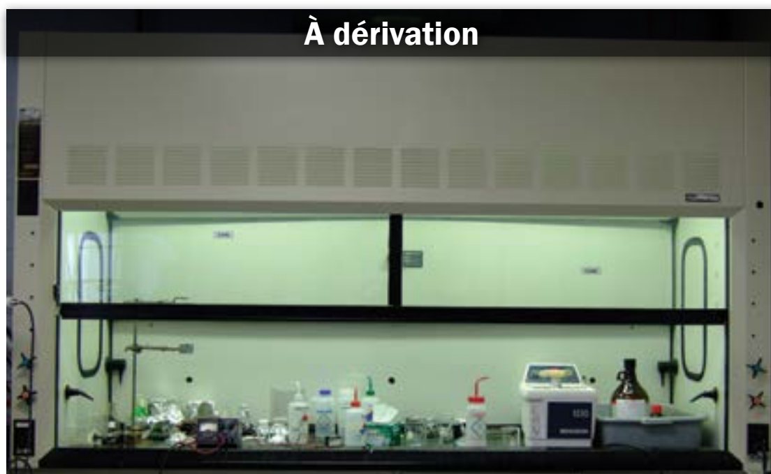
Figure 11. Hotte de laboratoire à dérivation (notez la chambre de dérivation au-dessus de la fermeture coulissante).
