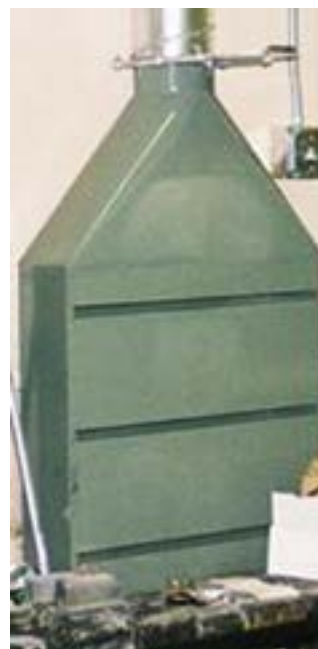
Figure 9. Hotte à captage extérieur (notez que la zone de travail se trouve en face de l'entrée de la hotte)
