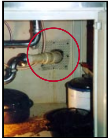
Use mallas de metal alrededor de las tuberías
