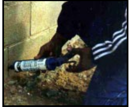
Rellene los huecos con yeso
