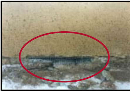
Doble la malla de metal y colóquela en los huecos en el cimient de las casas
