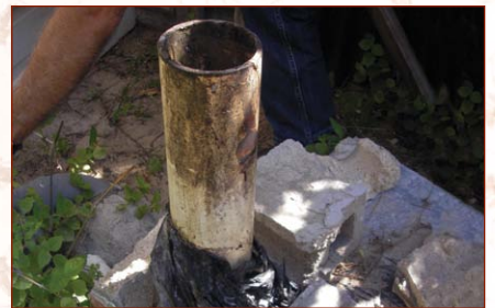
Respiradero sin tela metálica
