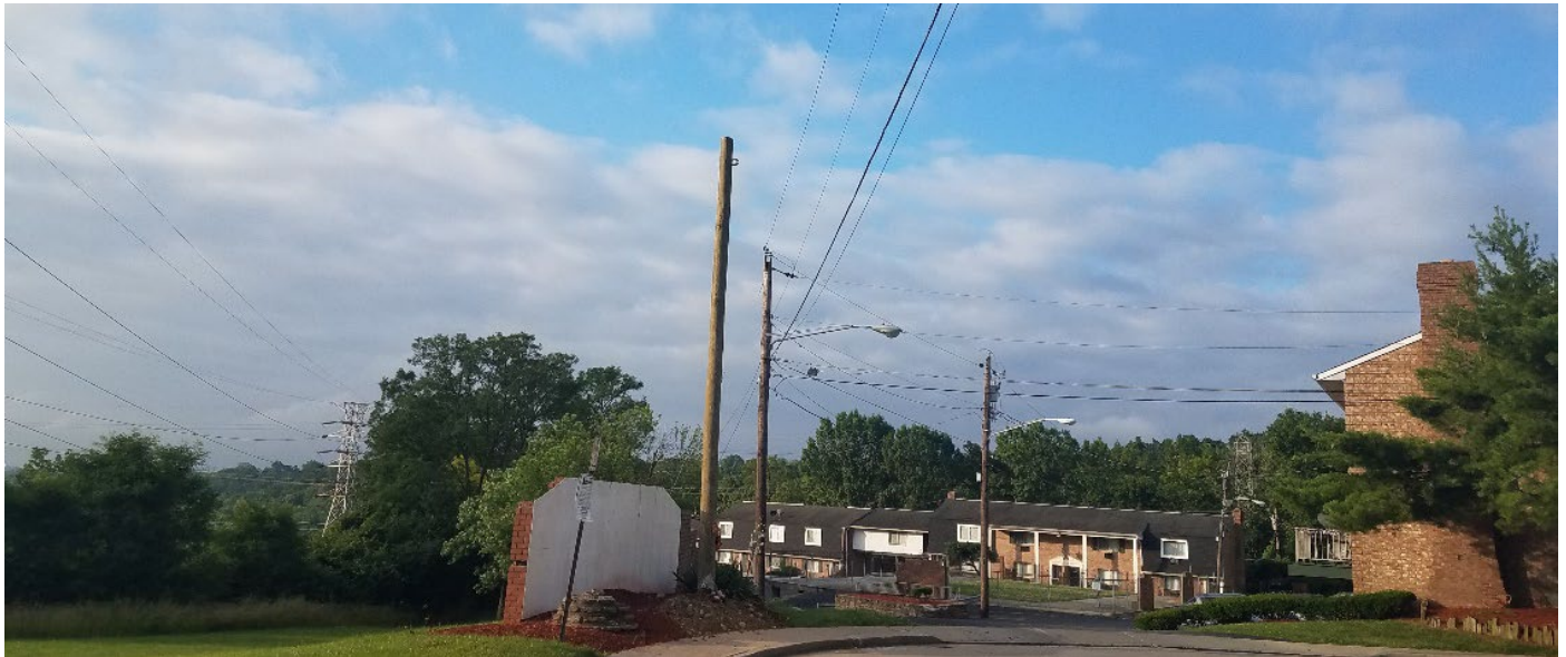
Foto 3. Foto de un poste para cámara nuevo al final de la calle sin salida. Cortesía del Programa de Reducción del Riesgo en Empleos Públicos
