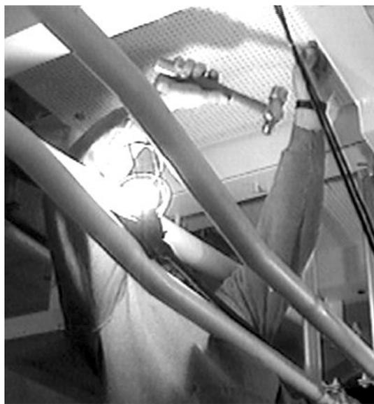
Figure 13. Insulation Installer Hammering Stud Caps Down
