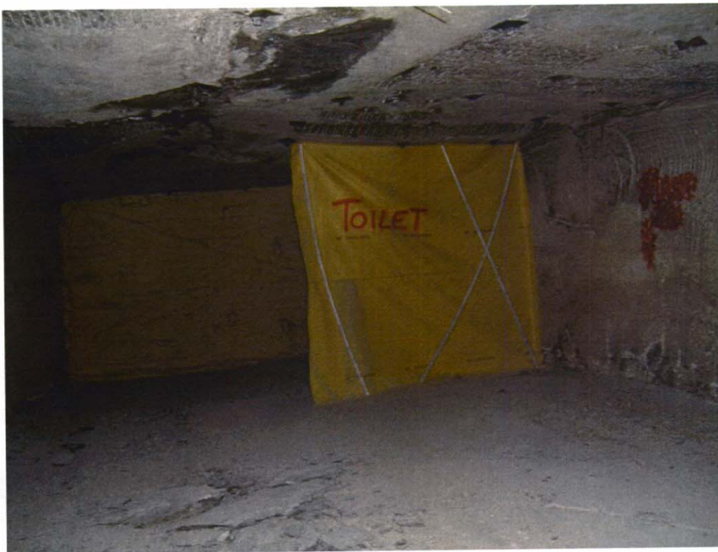
M20 Toilet Area
