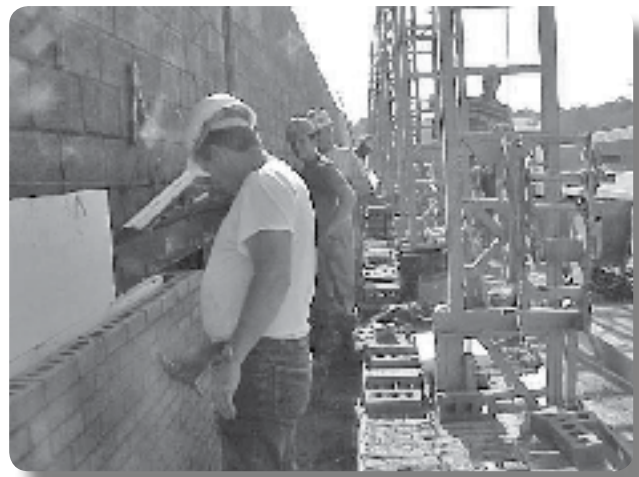
Solución: Los albañiles terminan el nivel superior en un andamio de niveles ajustables
