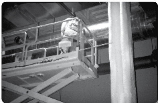
Los elevadores de personas brindan plataformas estables para realizar trabajos que requieren movimientos por encima de la cabeza y eliminan la necesidad de escaleras y andamios
