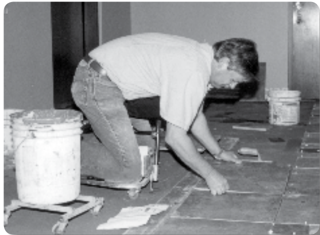
Solución: Plataforma rodante para arrodillarse durante la instalación de baldosas
