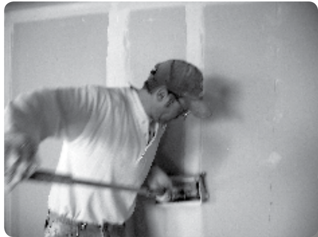
Problema: Acabado manual de paneles de yeso con el uso de cajas de compuesto para juntas
