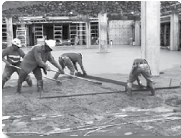
Problema: Uso de una niveladora manual
