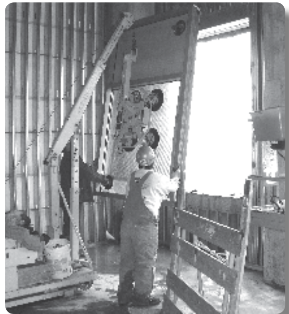
Un elevador motorizado con mecanismo al vacío evita levantar objetos manualmente
