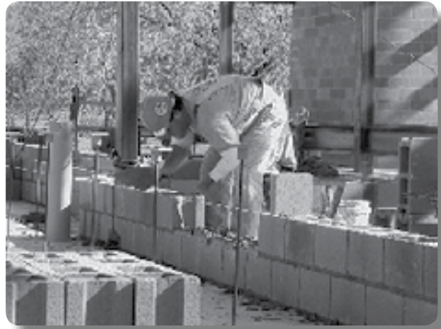
Problema: Instalación de bloques de concreto estándar
